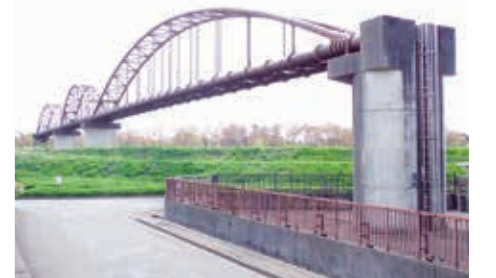
今宮橋水管橋全景
