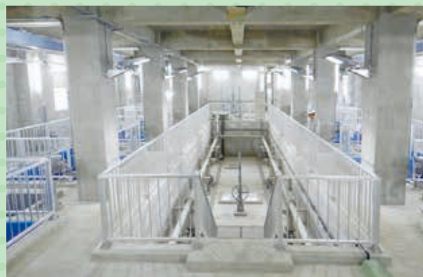
▲栃尾浄水場ろ過池機械・電気設備更新工事(栃堀地内)
