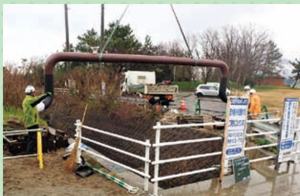
▲耐震管布設工事(寺泊荒町地内)
