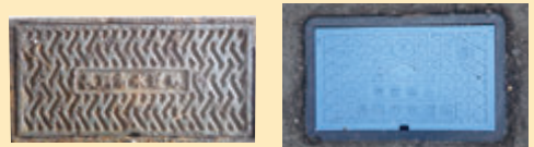
メーターボックスは、金属（鋳物）製またはプラスチック製です。
