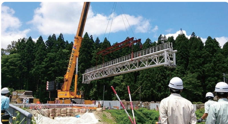
送配水管整備（鏡橋水管橋布設工事：長岡地域）
