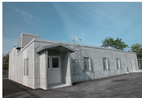
▲水道水の安定した供給をはかるため、大倉配水池(栃尾地域)を建設しました。
