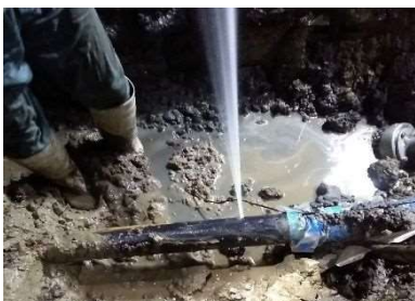
水道管修繕の様子
