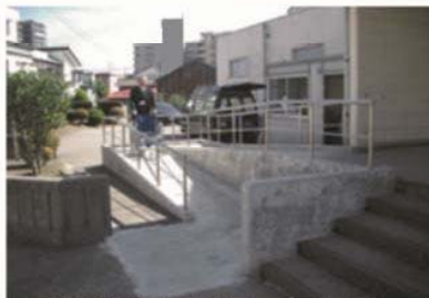
①出入口にスロープ設置
