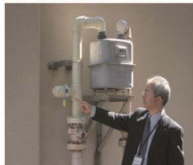
⑤LPガスの接続口を設置
