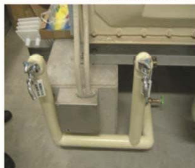
④受水槽に蛇口を設置
