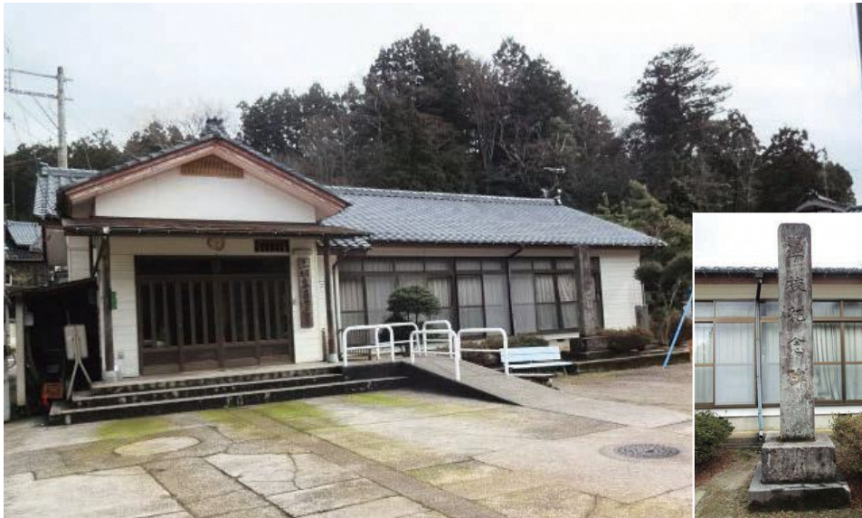
学校跡地に建てられた上桐公会堂(昭和63年3月15日竣工)
