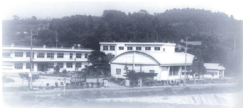
桐島小学校新校舎全景(昭和57年6月)
