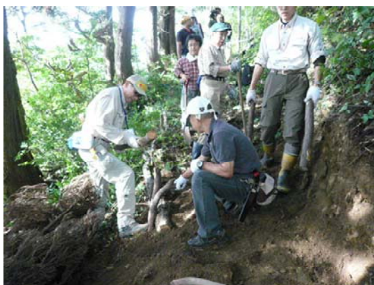
▲地域住民とボランティアによる遊歩道の復旧作業
