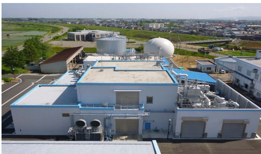
生ごみバイオガス発電センター
