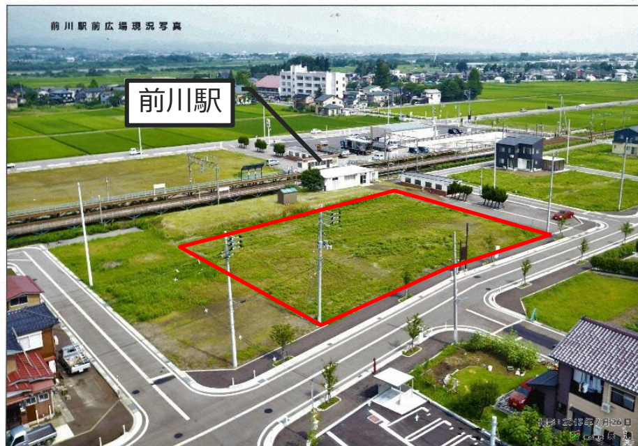
整備対象：前川駅周辺
