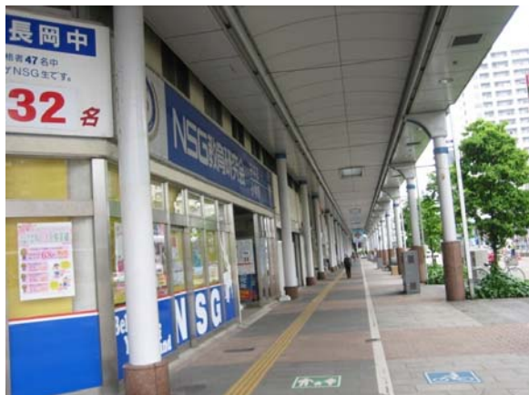
敷地南側（大手通り）
