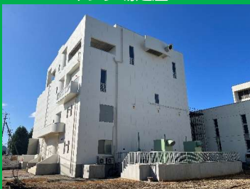
ポンプ場建屋
