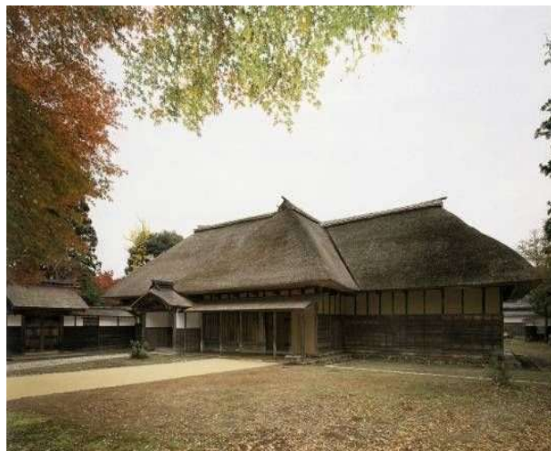
重要文化財「旧長谷川家住宅」
