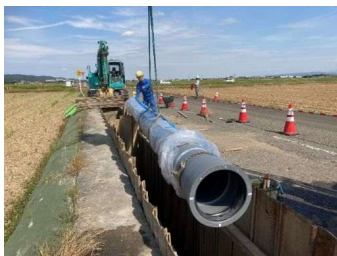
水道管（耐震管）の布設状況
