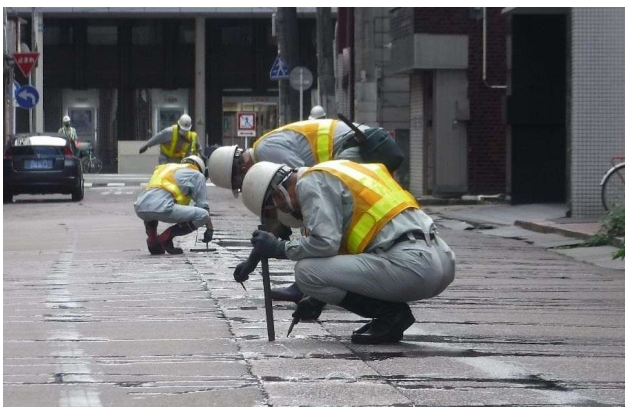
消雪パイプの点検
