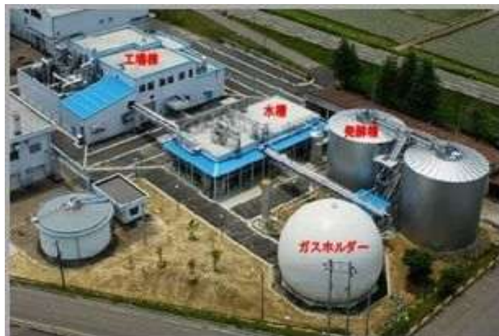
生ごみバイオガス発電センター
