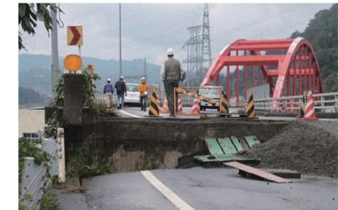
新潟県中越地震(小千谷市 国道117号) 出典:小千谷市復興計画の長期検証(総括) 平成26年10月
