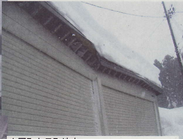
小国町七日町地内 鉄骨造1階建車庫損壊 およそ7.2m×7.2m 天井鉄骨の接続ボルトの破断 車2台が損傷を受けた 耐雪深1mのところ、1~1.5mの積雪があった
