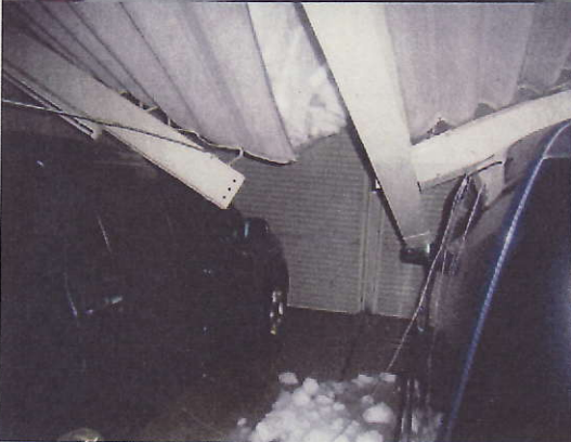
小国町七日町地内 鉄骨造1階建車庫損壊 およそ7.2m×7.2m 天井鉄骨の接続ボルトの破断 車2台が損傷を受けた 耐雪深1mのところ、1~1.5mの積雪があった
