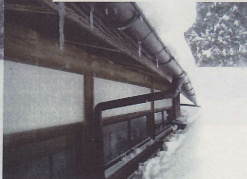
小国町七日町地内 木造2階建住家の1階下屋の垂木損傷L=5m 老人1人暮らし世帯 確認時は雪下ろし済み 緊急を要する損傷ではない
