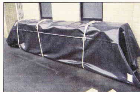
雨水の浸入を防ぐため、土木工事用シートで囲い固定しました。
