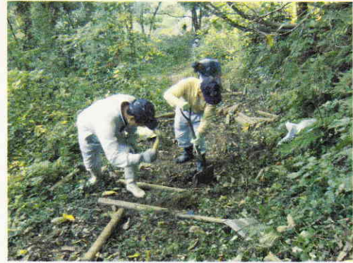
階段の設置 (東川口)
