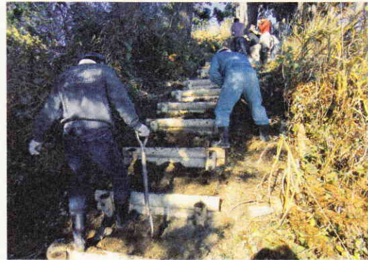
階段の設置 (木沢)
