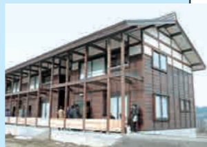
▲山古志の原風景に調和した外観で、屋根は落雪式、玄関には雪を防ぐ雁木が備えられています
