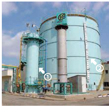
▲ガスを精製する①精製塔と②ガスホルダ
