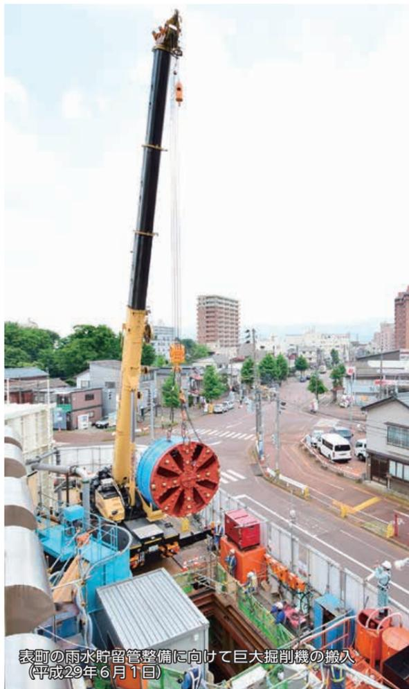
表町の雨水貯留管整備に向けて巨大掘削機の搬入 (平成29年6月1日)
