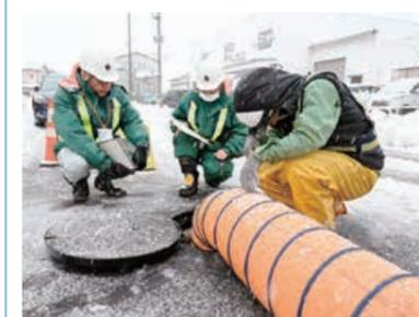
1月28日に埼玉県八潮市で発生した、下水道管の破損が原因とみられる道路陥没事故を受け、下水道管の点検を行いました。破損した場合に被害が大きくなる恐れがある口径1.5m以上の汚水管などを対象に、周辺の路面状況と、マンホール内で管や下水の流れに異常がないかを確認。点検した下水道管に異常はありませんでした。
