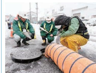
1月28日に埼玉県八潮市で発生した、下水道管の破損が原因とみられる道路陥没事故を受け、下水道管の点検を行いました。破損した場合に被害が大きくなる
