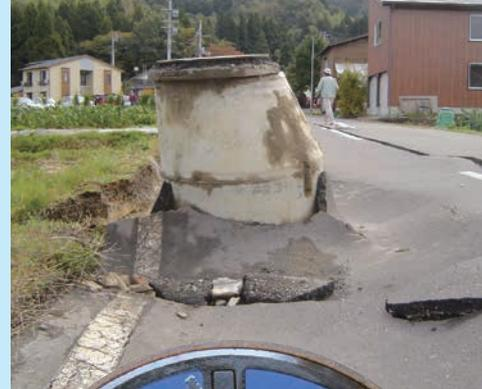
▲(左から) 大正13年の下水道工事、表町貯留管、中越大震災で隆起したマンホール
