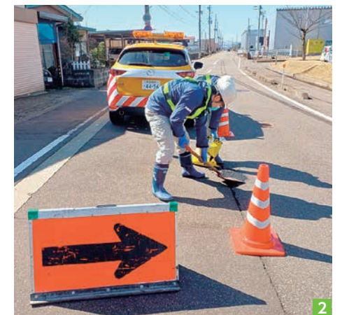
▲管理の一環で実施する道路パトロール。傷やへこみなどの欠陥の発見から修繕までを一体的に行うことで、素早い処置が可能になります
