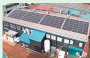
▲工場の屋根に設置した太陽光パネル。遮熱効果で空調効率も改善します
