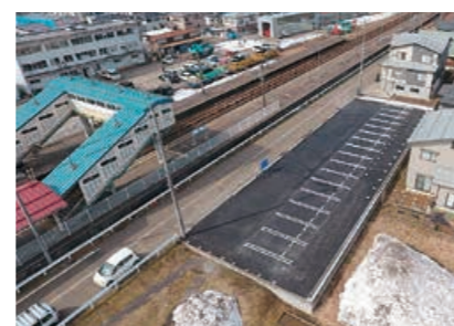
▲16台分の駐車場
