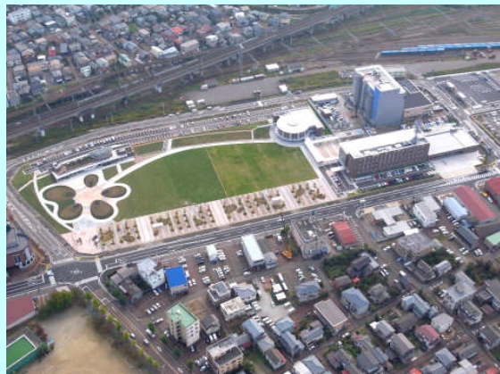
長岡防災シビックコア地区(上空写真)
