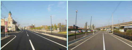
道路((都)溝橋袋町線) 歩道照明施設整備事業
