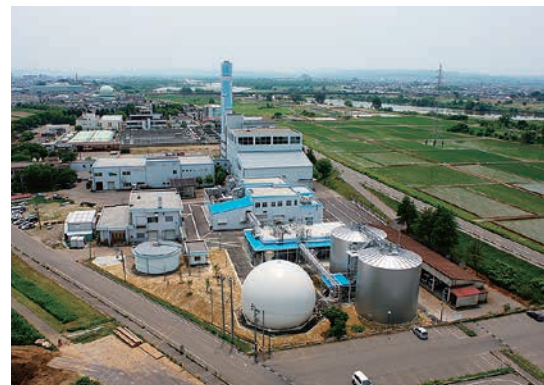
生ごみバイオガス発電センター
