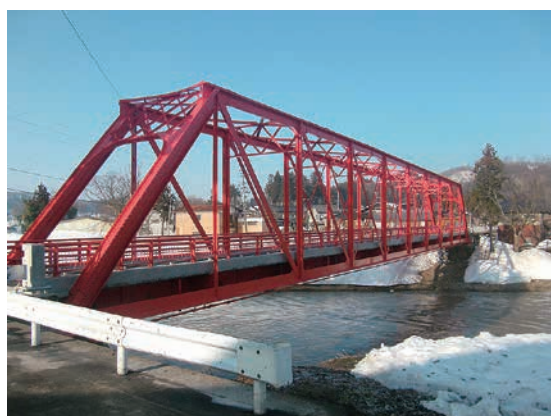
橋りょうの長寿命化の推進 (リニューアルした不動沢橋)
