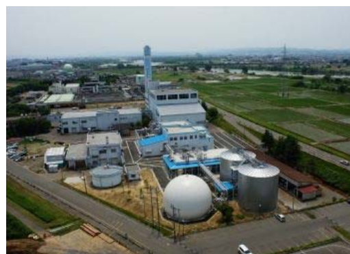
生ごみバイオガス発電センター
