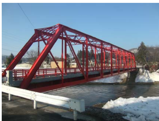
長岡の橋梁の長寿命化の推進 (リニューアルした不動沢橋)
