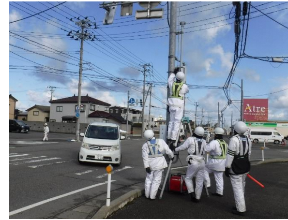
信号機の復旧
