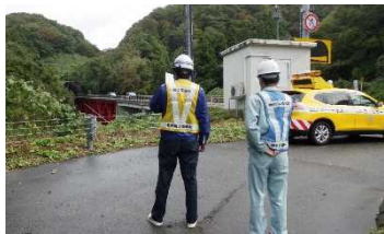
地震で被災した避難道路の啓開 (復旧)訓練を実施 (柏崎市)
