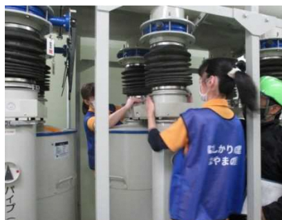
陽圧化装置の起動準備
