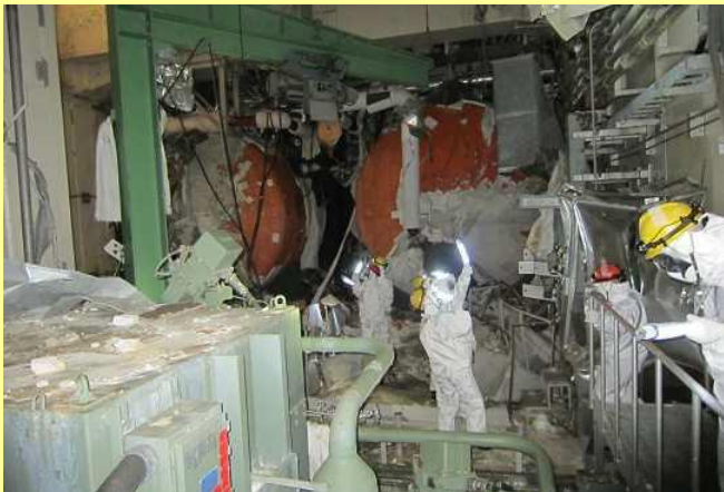
平成27年2月、1号機原子炉建屋内の現地調査
