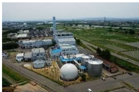
生ごみバイオガス発電センター
