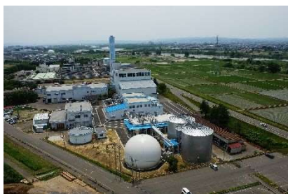
生ごみバイオガス発電センター
