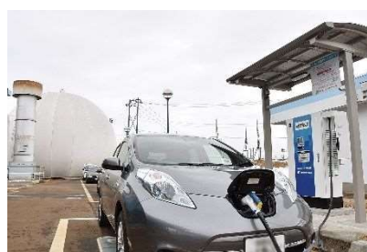
発電した電気を活用した 電気自動車用急速充電器
