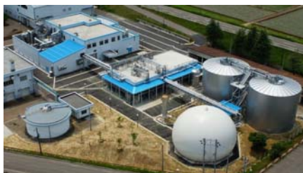
生ごみバイオガス発電センター
