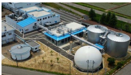
生ごみバイオガス発電センター
