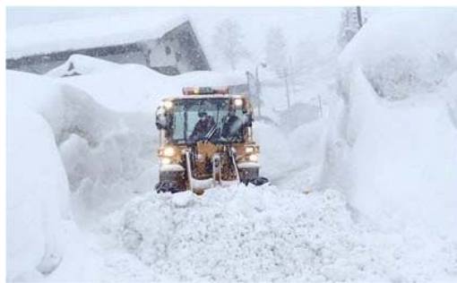
道路除雪の様子（令和4年2月 長岡市）
