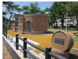
写真3 摂田屋公園整備
