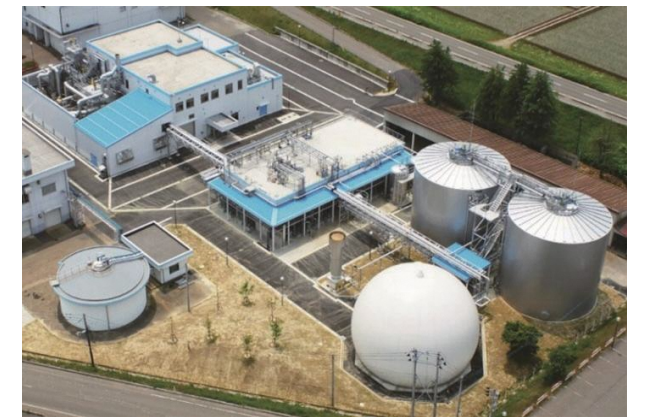
収集した生ごみを活用している生ごみバイオガス発電センター
