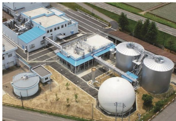
収集した生ごみを活用している生ごみバイオガス発電センター
