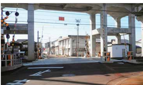
▲通学路の安全確保のため歩車分離した新町踏切
