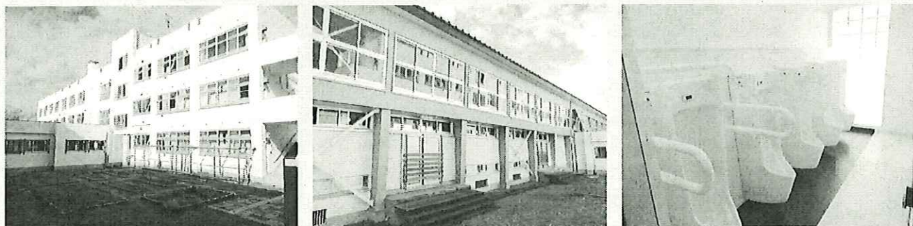
きれいに改修整備された校舎とトイレ
