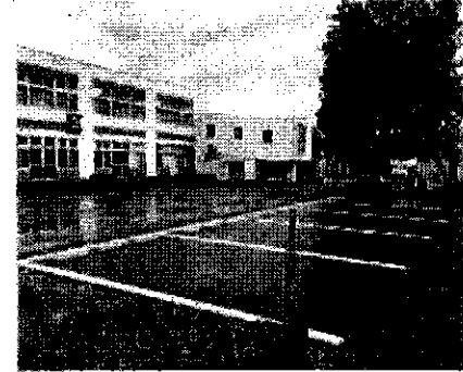
●宮内保育園の駐車場整備
