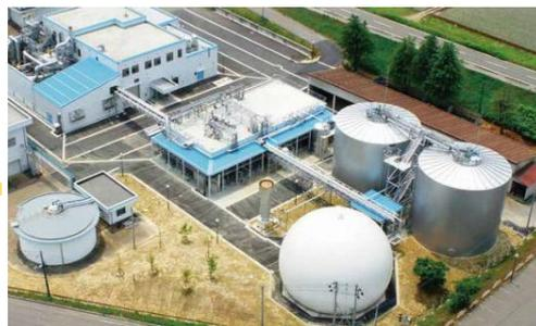
生ごみはバイオガス発電センターで発酵させメタンガスを発生させる。
