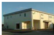
集出荷貯蔵施設
