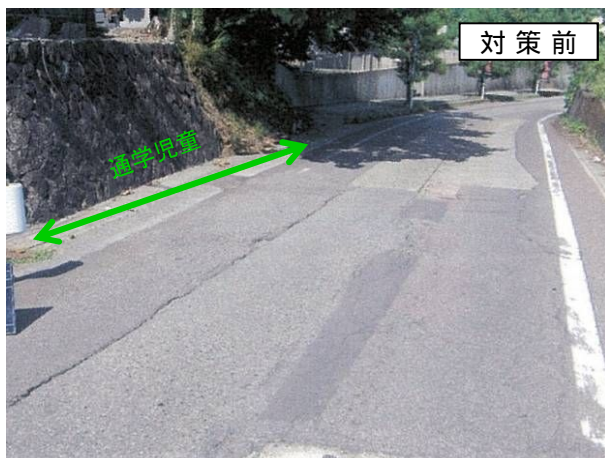
歩道がなく通学児童が危険である
