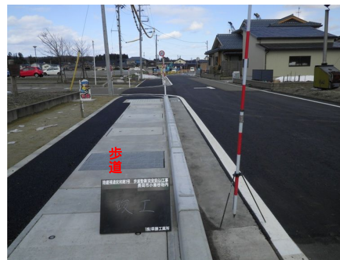
水路を暗きょ化し歩道を設置
