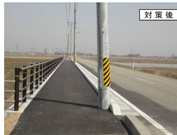
道路の法面幅を有効に活用し歩道を拡幅
