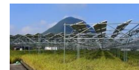
太陽光パネル
