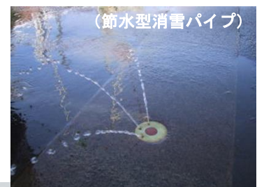
(消雪パイプによる除雪の様子 (長岡駅前))
